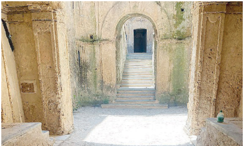
Palazzo Vitale Completati gli interventi di ristrutturazione
