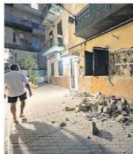
I danni prodotti dal sisma
