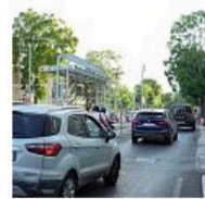
Il cantiere del Brt sul lungomare
