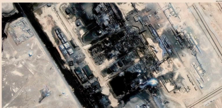
Il nuovo fronte. Una foto dei danni all'oleodotto East-West in Arabia Saudita, colpito dagli Houthi l'11 settembre
