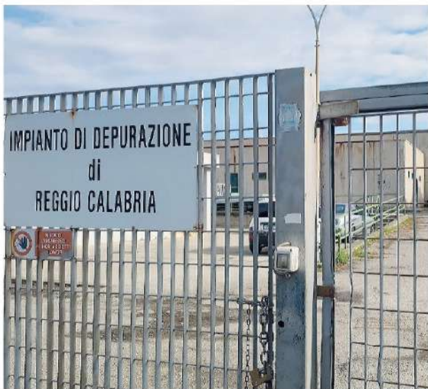
In emergenza Il depuratore di Ravagnese è il più grande della città
