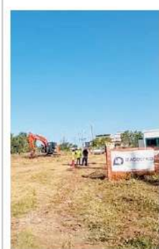
Palmi Il cantiere del Nuovo Ospedale della Piana
