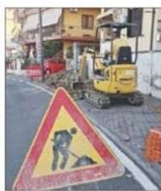
I lavori sui marciapiedi di Belvedere
